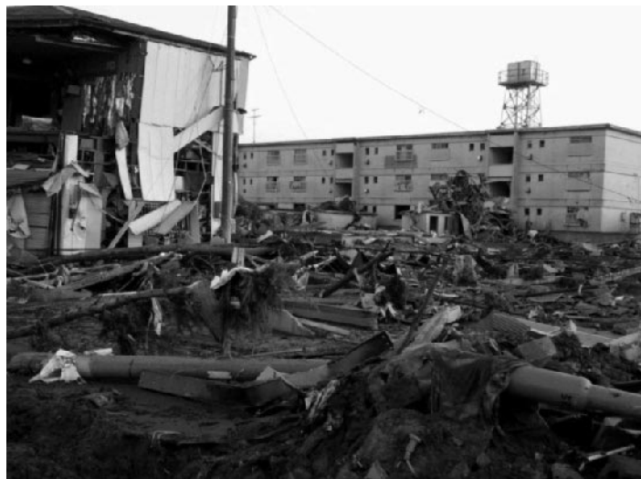
地震と津波により崩壊した宮城県名取市の惨状（撮影・加納浩志）
